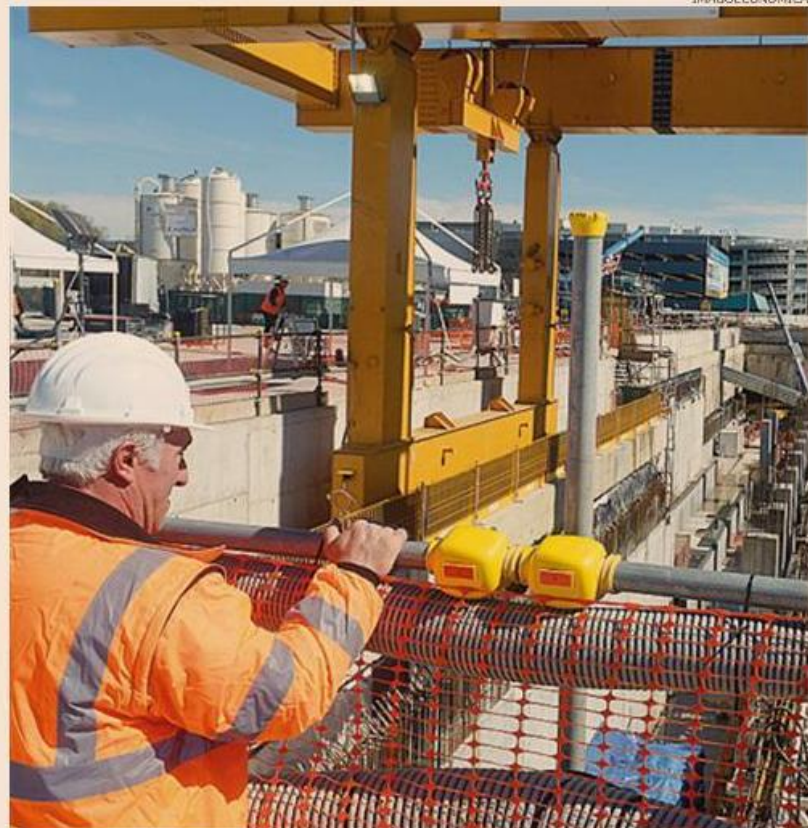
Flussi sorvegliati. La Metro 4 di Milano è tra i lavori super-monitorati
